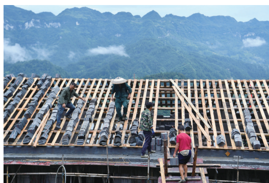
2020年8月20日,葫芦村官庄组,施工人员在为新房上瓦片。
