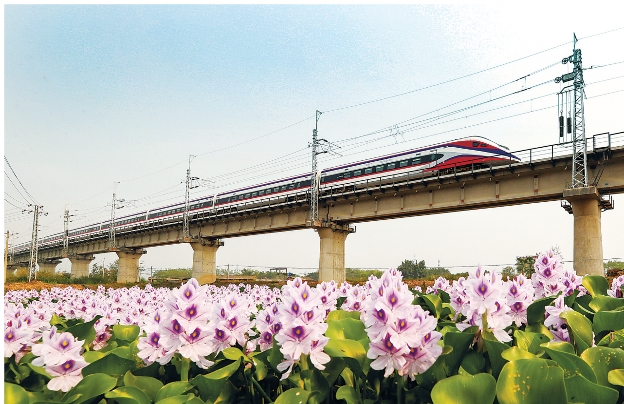
2023年4月13日，从老树万象站驶出的D888次“澜沧号”列车行驶在云南省西双版纳州境内的中老铁路橄榄坝特大桥上。
