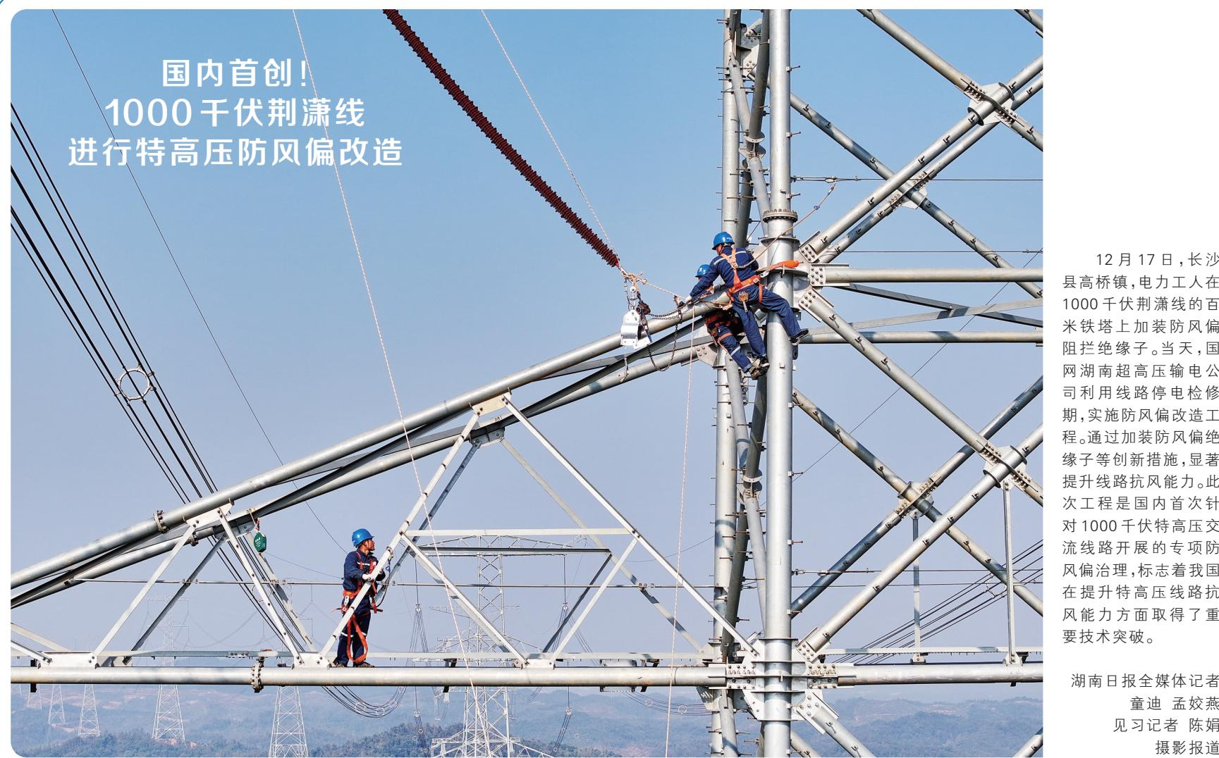
12月17日,长沙县高桥镇,电力工人在1000千伏荆潇线的百米铁塔上加装防风偏阻拦绝缘子。当天,国网湖南超高压输电公司利用线路停电检修期,实施防风偏改造工程。通过加装防风偏绝缘子等创新措施,显著提升线路抗风能力。此次工程是国内首次针对1000千伏特高压交流线路开展的专项防风偏治理,标志着我国在提升特高压线路抗风能力方面取得了重要技术突破。
