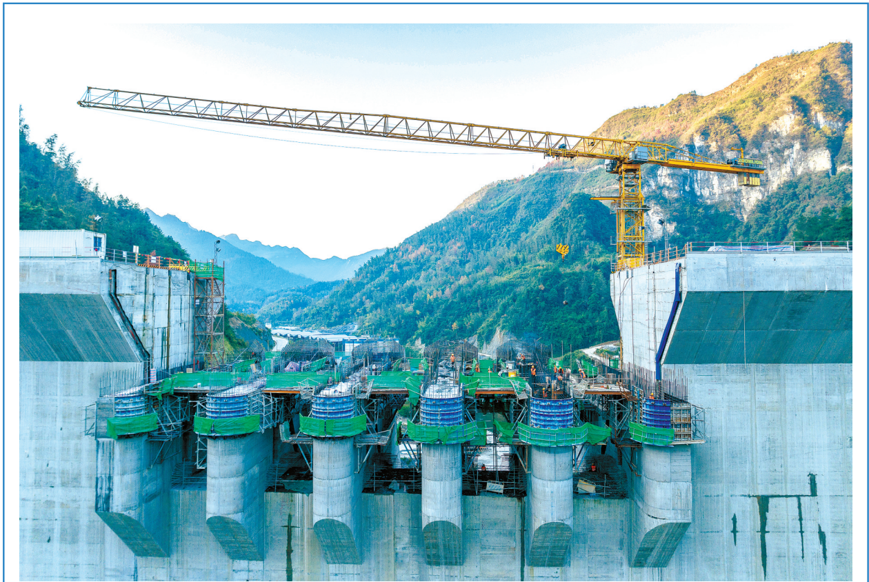
冬修水利 11月28日,吉首市矮寨镇大兴寨水库工程建设现场,工人正在进行8#9#溢流坝段施工。初冬时节,工程建设单位科学调度施工力量,利用晴好天气和枯水期窗口,确保重点水利工程项目高效推进。彭璟 摄(湖南图片库)
