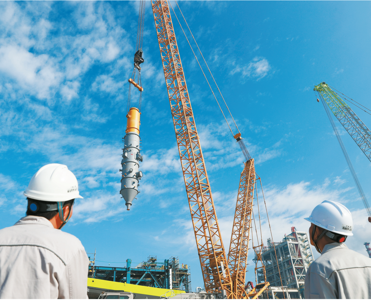
11 月 24 日，湖南石化生物物质气化柔性平台建设项目首台重达 95 吨的大件设备转化炉，成功吊装就位。目前，该项目钢结构已完成 80%，预计 12 月 5 日前实现气化框架封顶。 彭展 邓骏 摄影报道（湖南图片库）
