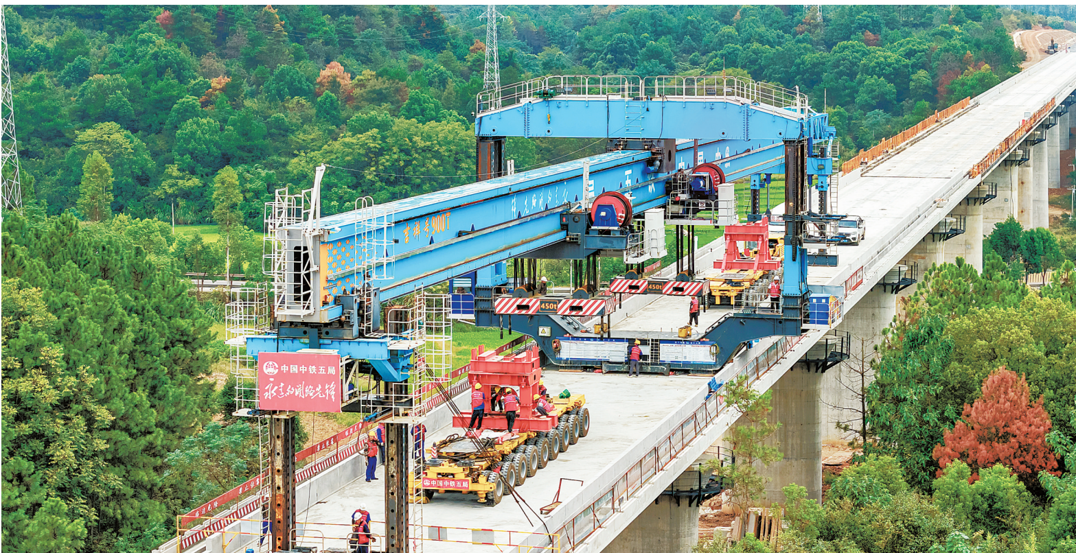
9月20日，东安县芦洪市镇邵(阳)永(州)高铁柘林坪特大桥施工现场，由中铁五局承建的特大桥完成最后一根箱梁架设，标志着邵永高铁首座特大桥箱梁架设完工，为加快推进邵永高铁建设奠定了基础。
