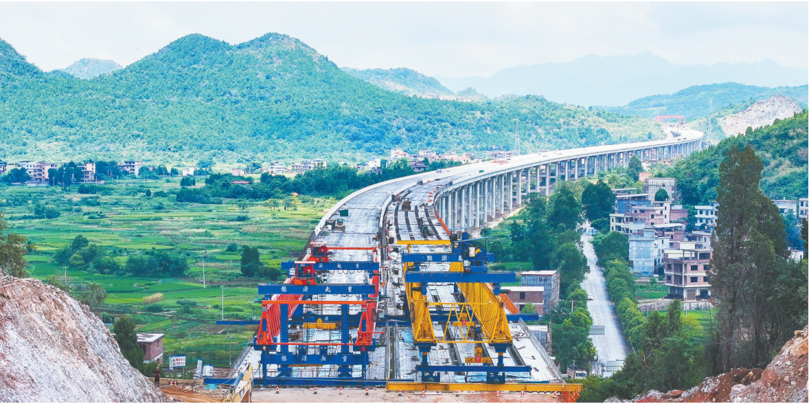
7月30日，新田县龙泉街道刘家桥村，桂（东）新（田）高速关键控制性工程——刘家桥特大桥实现全幅贯通。桂新高速公路是湖南省“十四五”重点项目，全长2377.5米，采用预制梁拼装工艺施工。刘贵雄 摄（湖南图片库）
