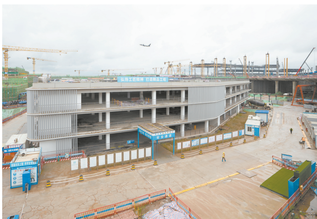
6月19日，长沙机场改扩建工程综合交通枢纽(GTC)主体结构已全面完成。目前，T3航站楼正按整体进度计划稳步推进。项目预计2026年投入运营。湖南日报全媒体记者 辜鹏博 摄
