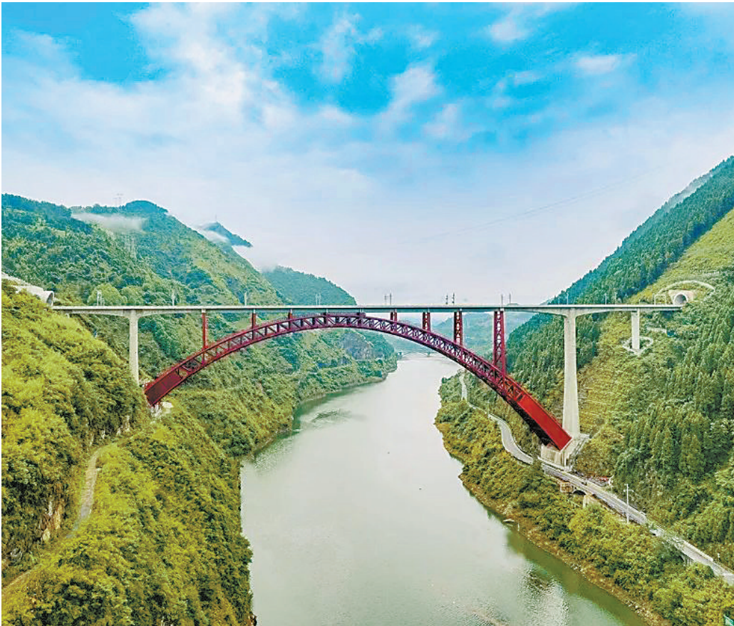
张吉怀高铁芙蓉镇西水大桥。(资料图片)
