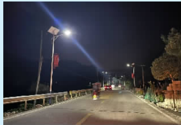
乡主干道沿线加装路灯后车辆、行人夜间出行现状。
