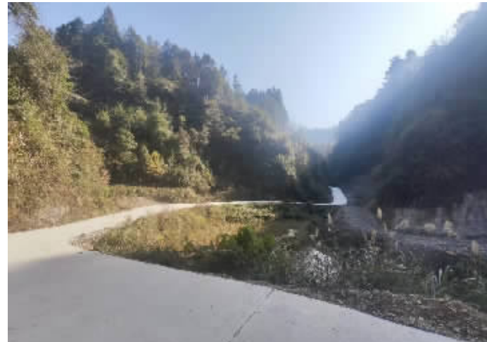
改造后的新路。
