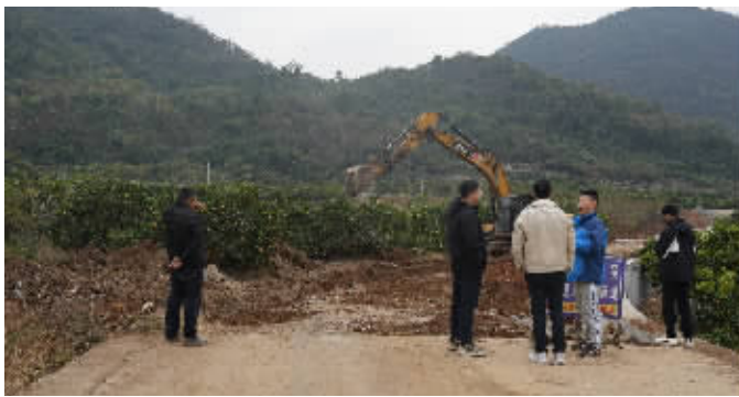
江永县人大和纪委干部现场监督断头路施工。
