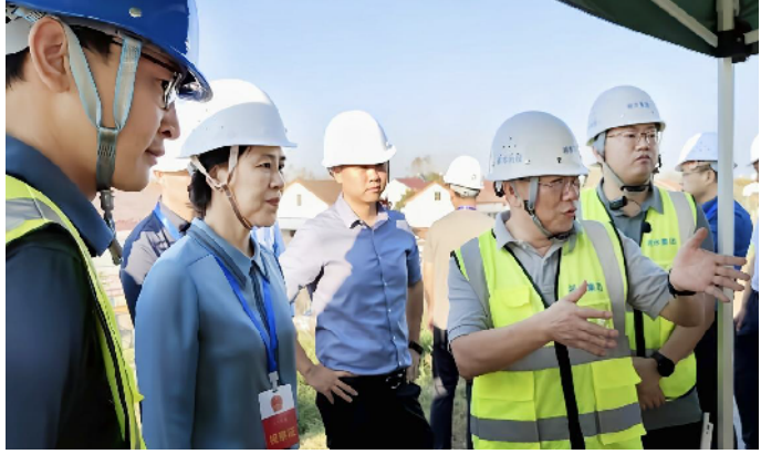
水利项目建设方向武陵区人大一行介绍相关施工情况。
