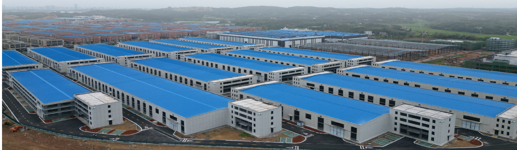
湘潭柏屹自主创新园三期——智能装备配件园实景。
