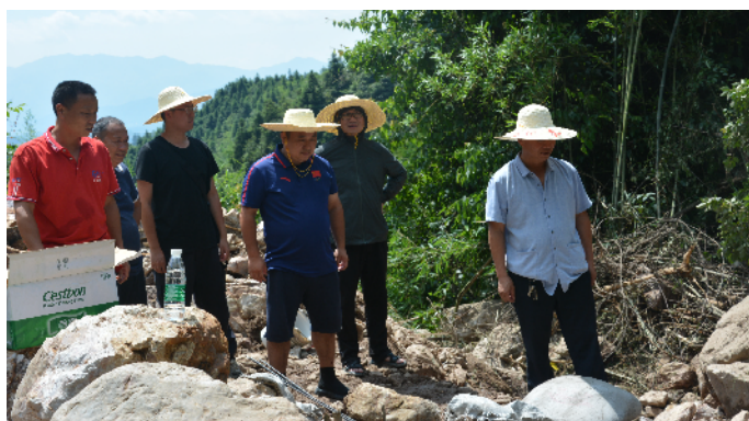
重修居民饮水点施工现场。
