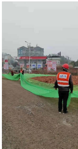
建筑工地覆盖防尘网。
